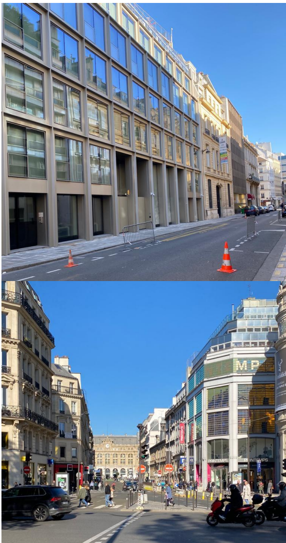
Figura 28: Perspectivas de novas construções no centro histórico de Paris.
