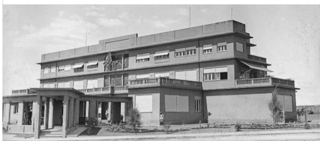
Figura 4: Palácio do Governo durante a construção da cidade.
