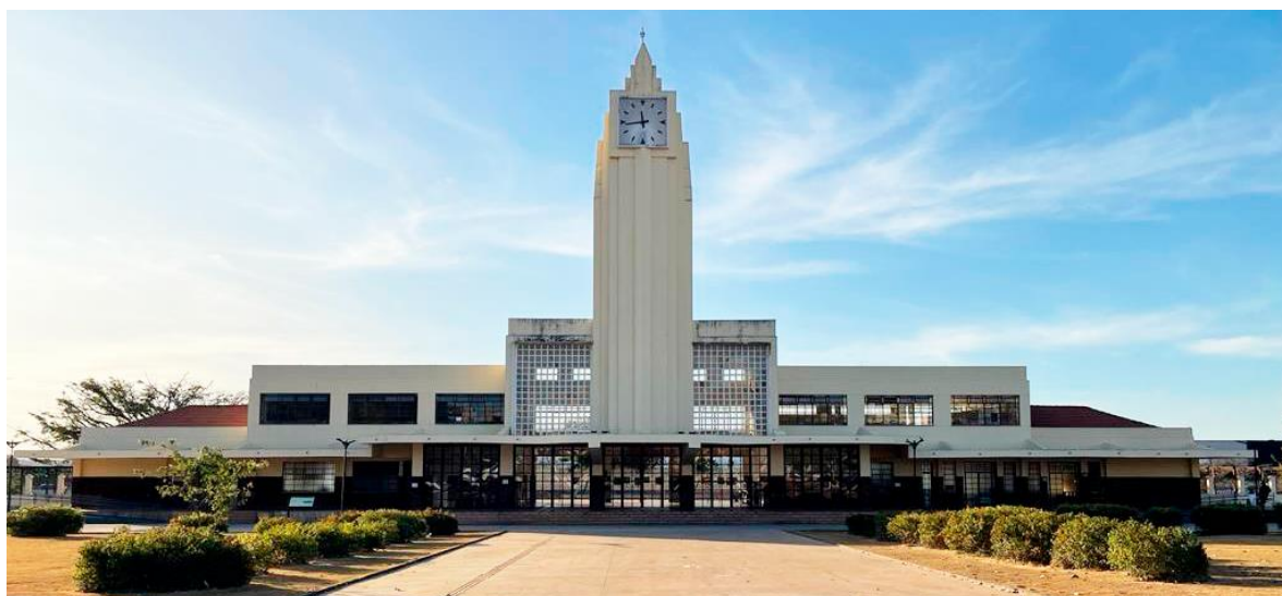
Figura 56: Antiga Estação após a restauração, em 2019.
