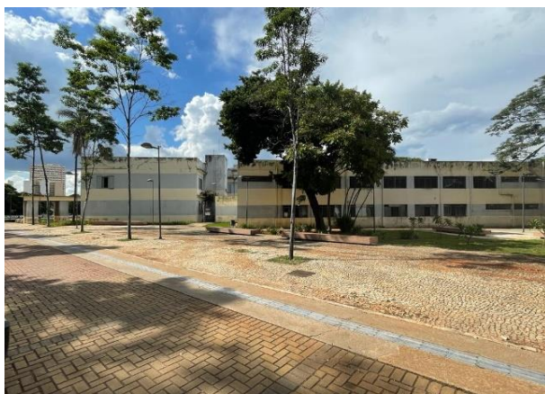
Figura 41: Fachada posterior do edifício da antiga Secretaria Geral à esquerda e Anexo à direita.
