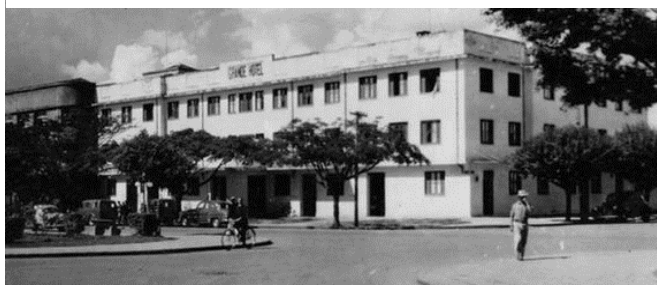
Figura 5: Edifício do antigo Grande Hotel
