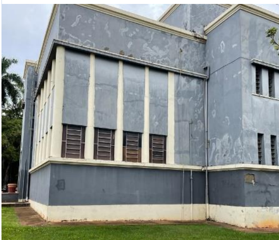
Figura 44: Vistas das infiltrações externas no Museu Zoroastro Artiaga.
