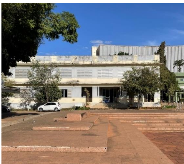
Figura 40: Fachada frontal do edifício da antiga Secretaria Geral.
