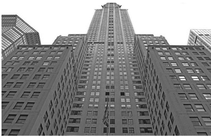
Figura 7: Perspectiva do Edifício Chrysler - Primeiro arranha-céu norte americano produzido durante o período déco .
