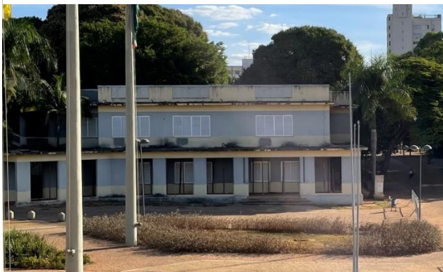
Figura 38: Edifício do antigo Fórum e Tribunal de Justiça, visto da Secretaria Geral.
