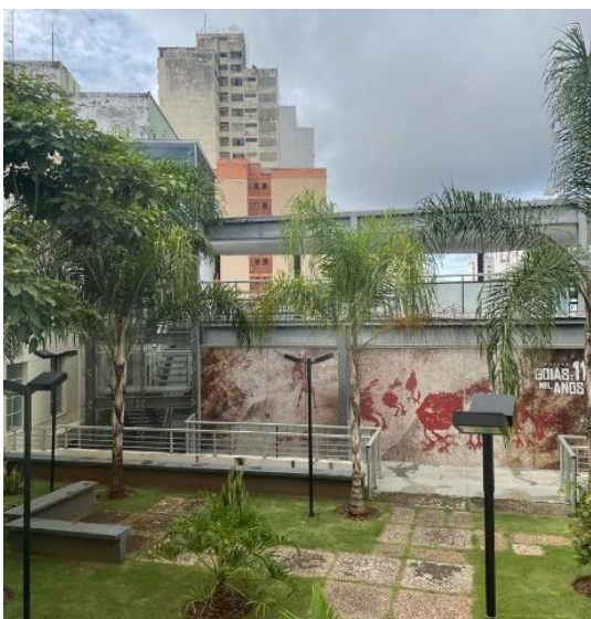
Figura 49: Pátio interno após restauração.
