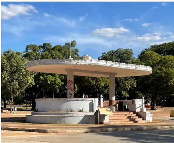
Figura 54: Perspectiva do Coreto antes da pintura, em 2023.
