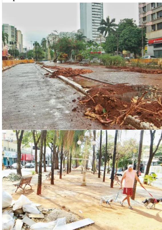
Figura 24: Retirada de árvores em trecho da Avenida Goiás e canteiro central, respectivamente.
