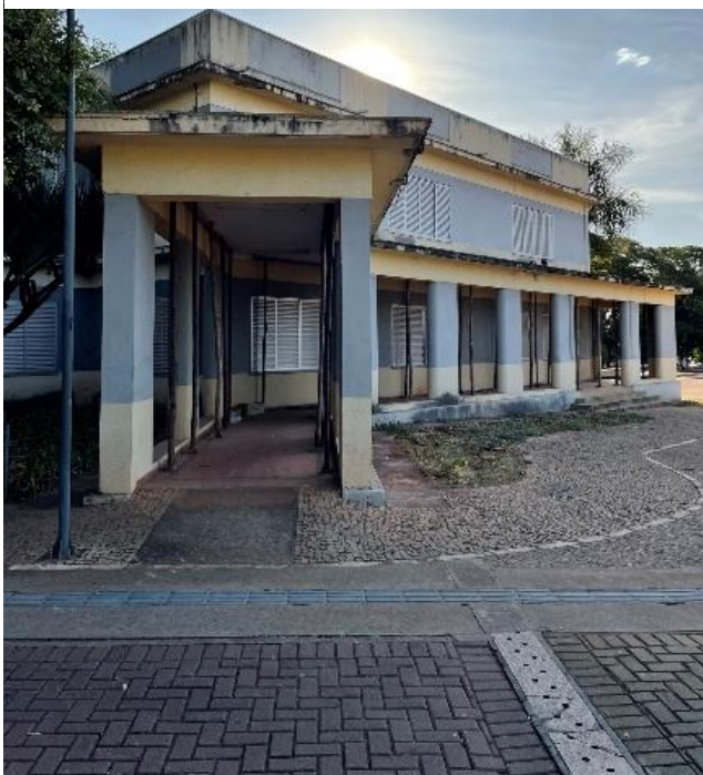
Figura 39: Perspectiva da colonata de acesso, com escoras de madeira.
