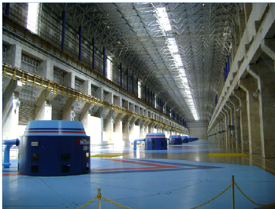
Fotografia 3: Máquinas da segunda etapa da construção da UHE de Tucuruí.
