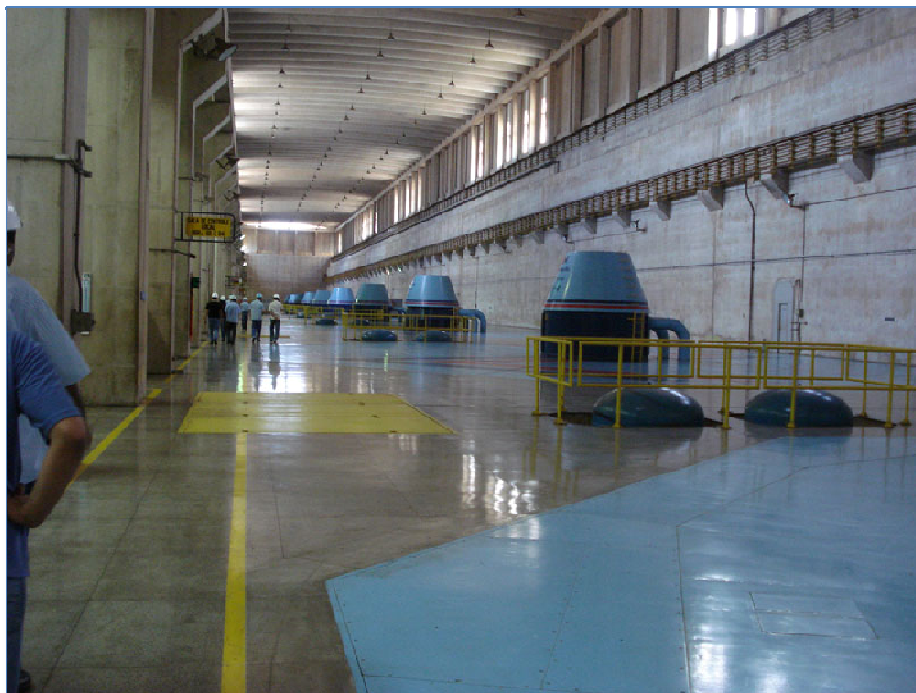
Fotografia 2: Máquinas da primeira etapa da construção da UHE de Tucuruí.
