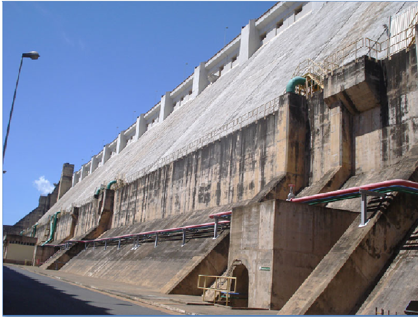
Fotografia 1: Visão interna da barragem da UHE de Tucuruí.
