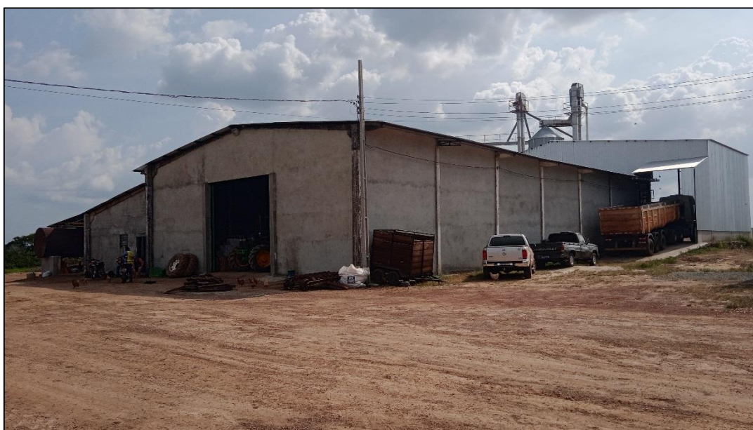
Figura 42 – Galpão de estocagem de um grande produtor em Vitória do Mearim
