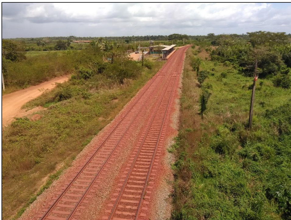
Figura 6 – Vista da Estrada de Ferro Carajás no povoado Bubasa em Arari
