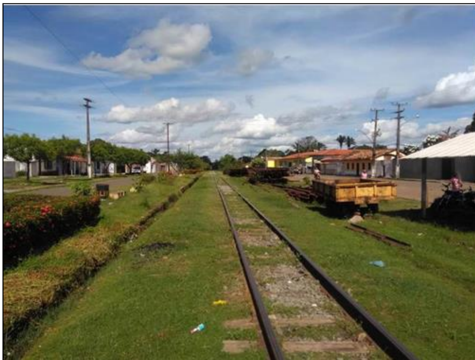
Figura 27 – Vista da Estrada de Ferro São Luís – Teresina na Praça João Lisboa em Pirapemas
