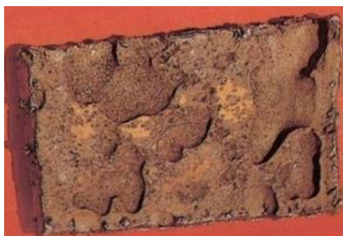
Figura 2 - Corrosão por placas
