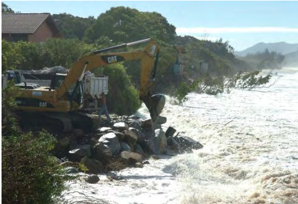
Figura 4 - Pedras são colocadas para conter o avanço do mar, Praia de Armação em 28/05/2010.
