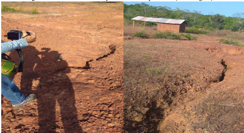
Figura 2 – Processos erosivos potencializados pela remoção da vegetação.
