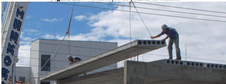
Figura 2.17 – Colocação de painéis alveolares
