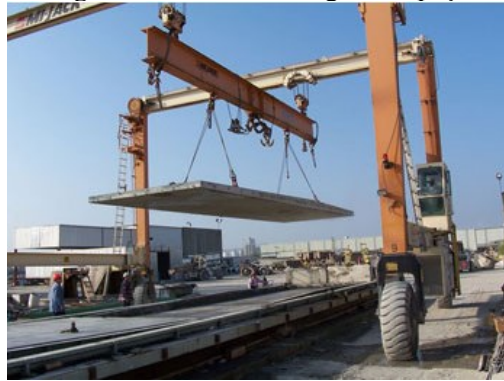
Figura 2.9 – Desmoldagem da peça
