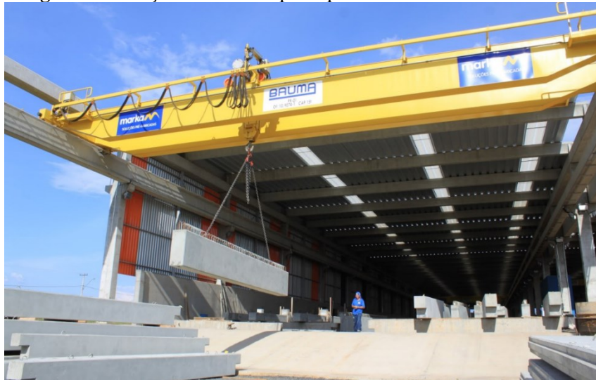
Figura 2.10 – Içamento e transporte para o local de armazenamento
