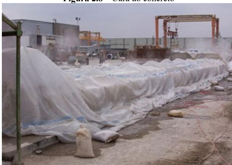
Figura 2.8 – Cura do concreto
