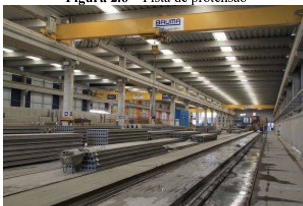
Figura 2.6 – Pista de protensão
