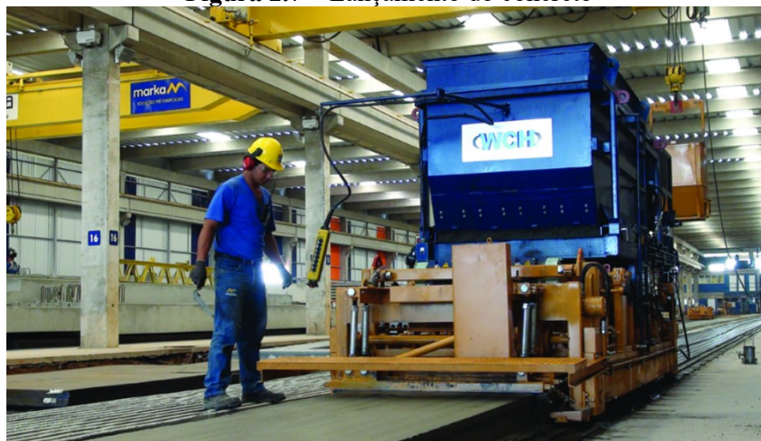
Figura 2.7 – Lançamento do concreto
