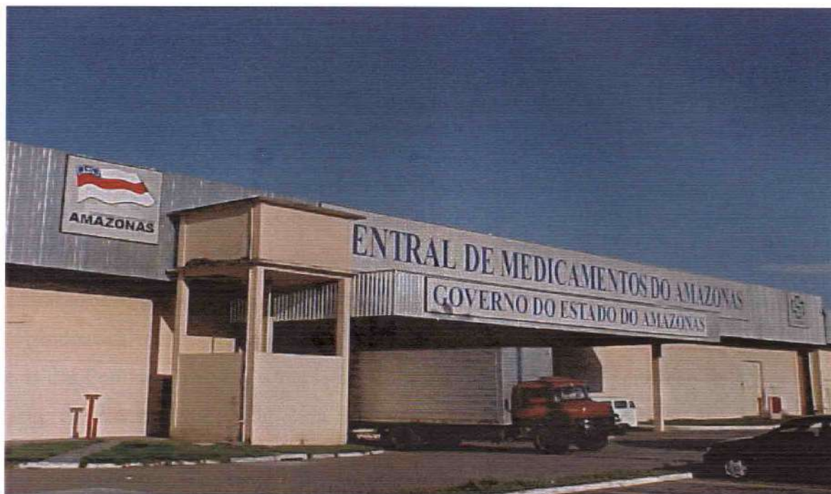
Foto 1 – Fachada Externa da Central de Medicamentos do Amazonas Fonte: CPD/CEMA/SES/AM.
