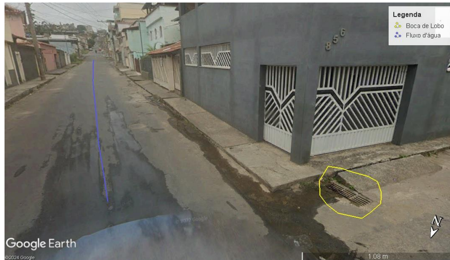
Figura 23: Boca de lobo na rua transversal ao fluxo d'água. Fonte: Elaborado pelo autor (2023).
