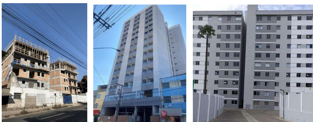
Figura 26: Edifícios recentes no Matosinhos (primeiro edifício ainda em construção, segundo edifício construído em 2024 e terceiro edifício construído em 2022). Fonte: Acervo do autor (2024).
