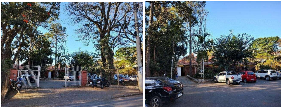
Figura 01: Fachada da Escola Estadual Governador Milton Campos. Fonte: Acervo do autor (2024).
