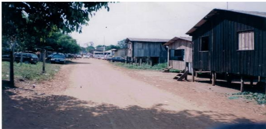
Figura 12 - Estrutura das casas na antiga vila
